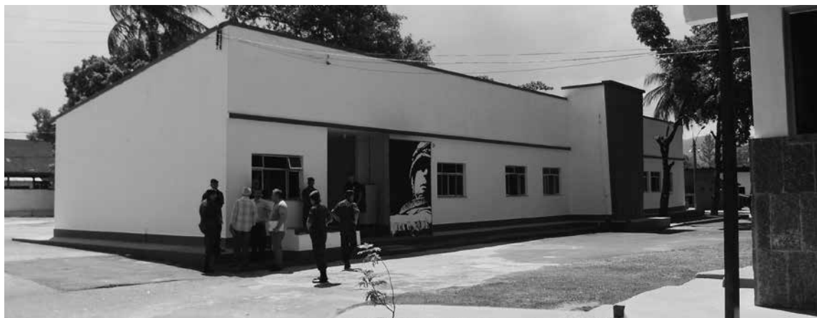
Parte anterior do prédio. Fonte: Arquivo CNV
