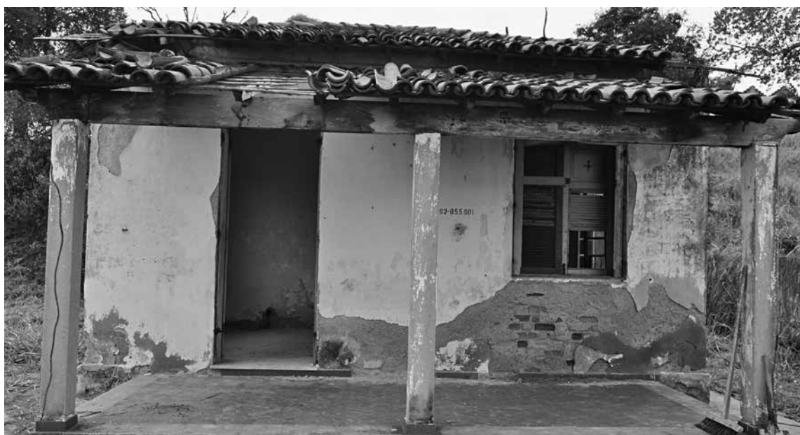
Vista frontal da edificação. Fonte: Arquivo CNV
